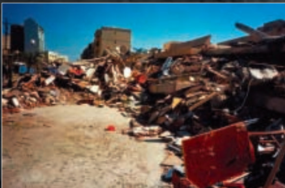
Abbildung 1: Zerstörte Häuser in der Stadt Boumerdes in Algerien. Das Beben vom 21. Mai 2003 der Magnitude 6,8 hat mehr als 2000 Menschen getötet. Der Schweizerische Erdbebendienst ist zusammen mit dem Schweizerischen Korps für Humanitäre Hilfe innert 24 Stunden nach dem Hauptbeben in Algerien angekommen, um dort Nachbeben zu messen und so mehr über das tektonische Umfeld zu lernen (Foto: Souad Sellami, SED).
